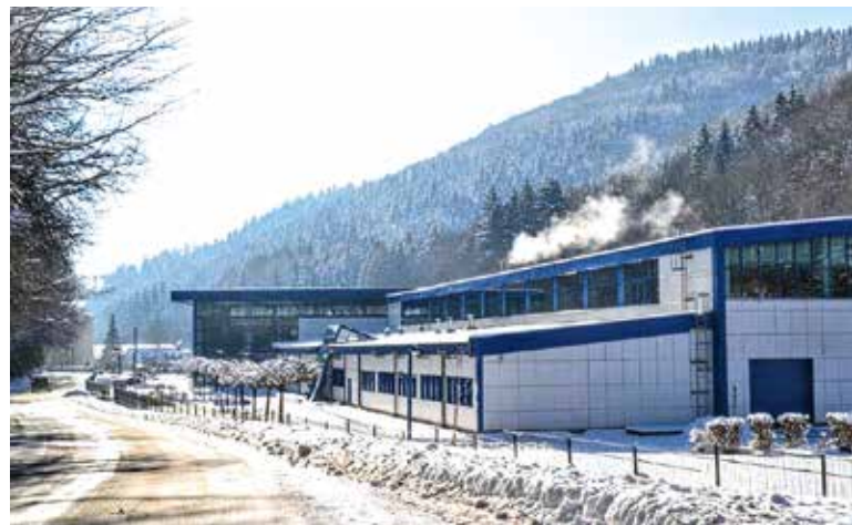
Fernwasserzweckverband © David Lehmann
