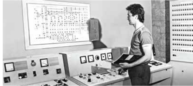
Schaltwarte ehemalige Gewürzmühle, Fotoquelle unbekannt
