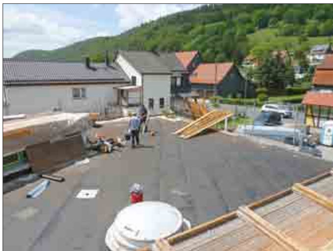
Vorbereitungsarbeiten zum Aufstellen der Ständerwände
