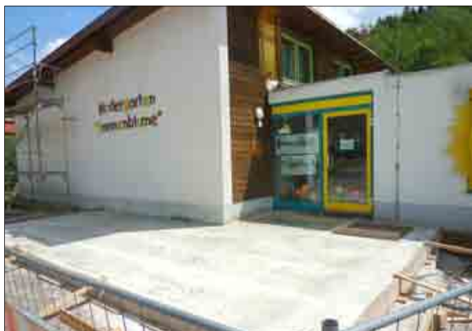
Bodenplatte des neuen Eingangsgebäudes
